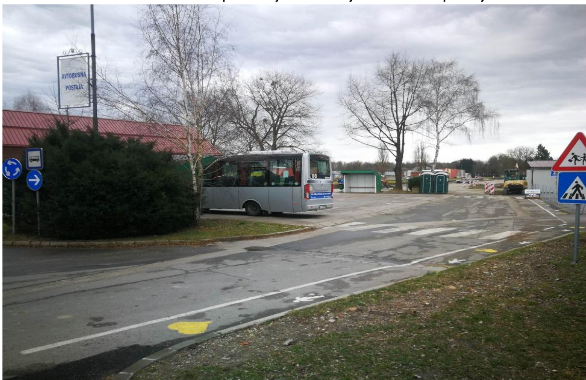
Spremenjena lokacija avtobusne postaje
